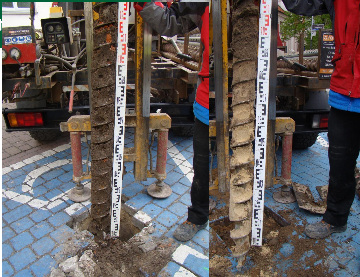
Wiercenia geologiczne przed rozpoczęciem badań wykopaliskowych
